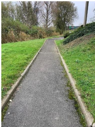
Le cheminement extérieur est d'une largeur de 1m52 ce qui permet à un fauteuil roulant de circuler sans difficultés.
